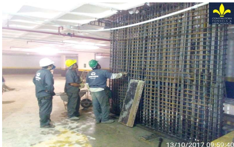
Figura 25: Armação do pilar PN304.
