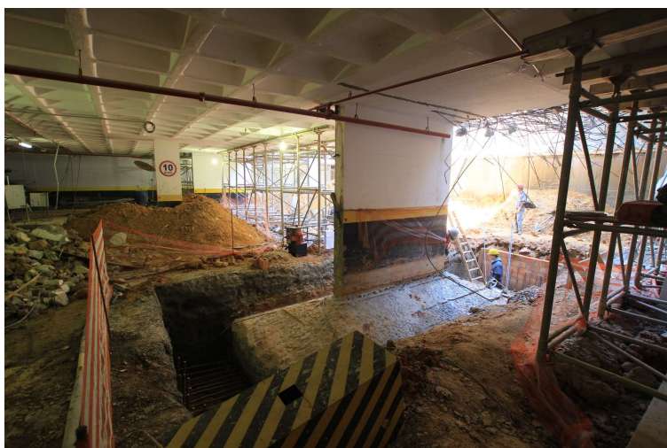
Figura 14: Travamento horizontal dos pilares no subsolo.
