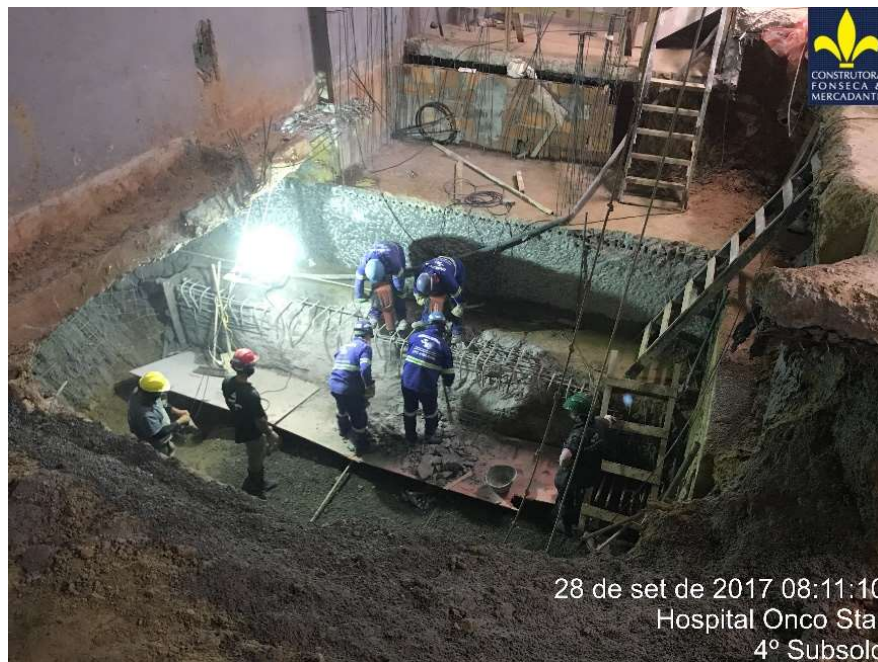
Figura 21: Execução do reforço estrutural apontado em texto.
