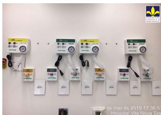
Figura 55: Instalação de gases medicinais as built .
