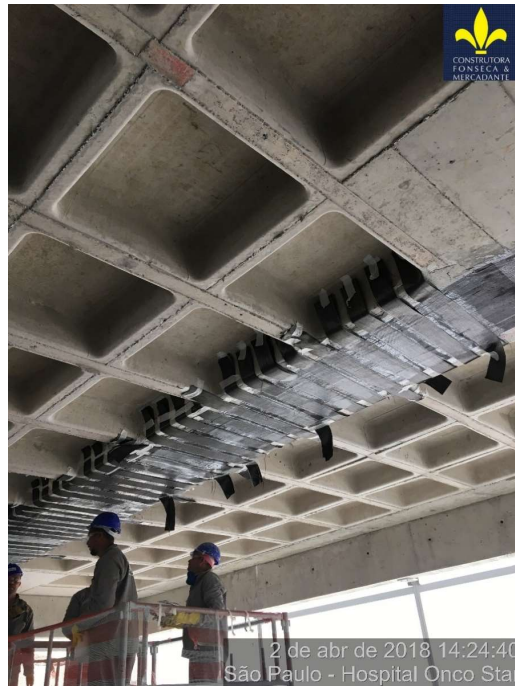
Figura 30: Disposição final do reforço estrutural.
