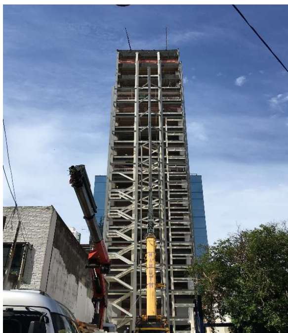
Figura 17: Montagem da estrutura metálica.
