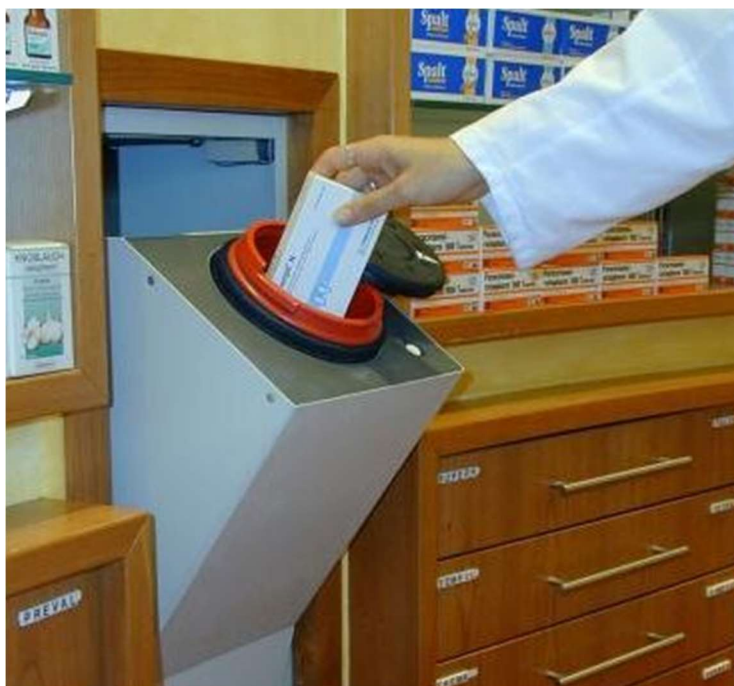
Figura 56: Medicamento sendo enviado através do correio pneumático para outros locais do hospital. Fonte: Aerocom
