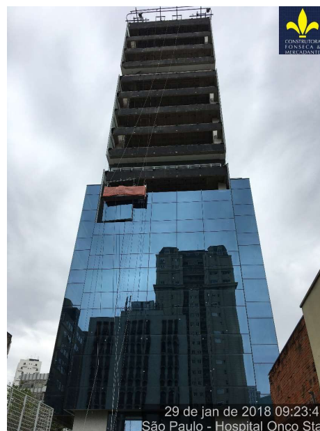
Figura 10: Retirada do revestimento de pele de vidro na fachada.
