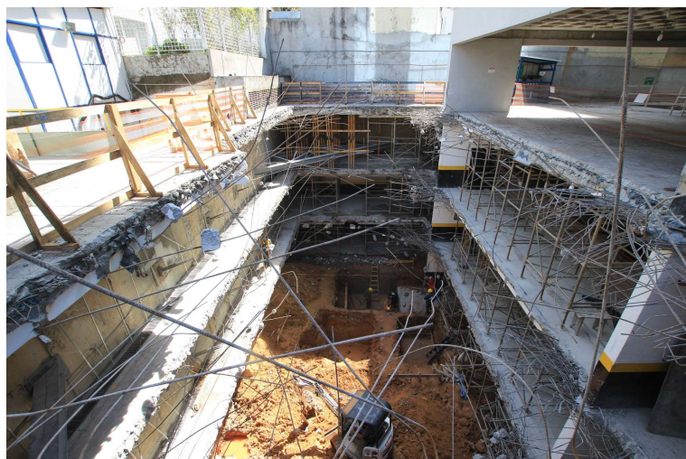
Figura 13: Lajes demolidas para atingir a cota das sapatas.
